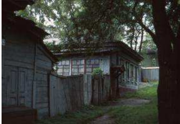
alte Holzhäuser stammen aus der Gründungszeit
