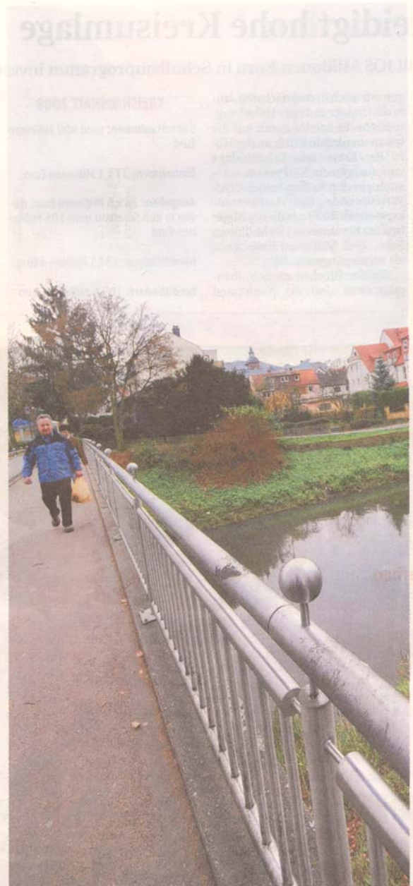
Streitpunkt „Neue Mitte“: Hier würde die Nidda überbaut. MÜLLER
