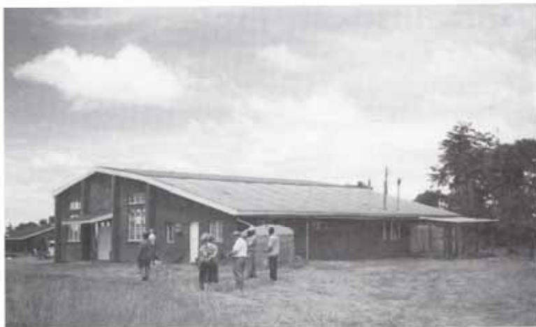
Blick auf das Hauptgebäude der Behindertenschule in Eldoret. Stand: 1997
