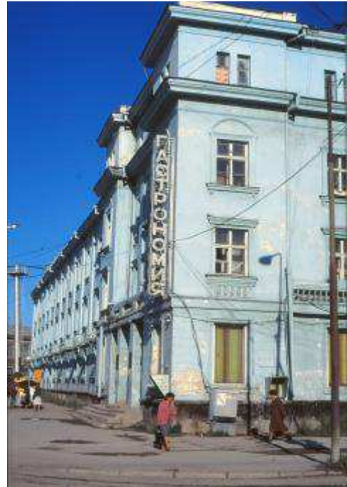
Bauten aus der Stalinära
