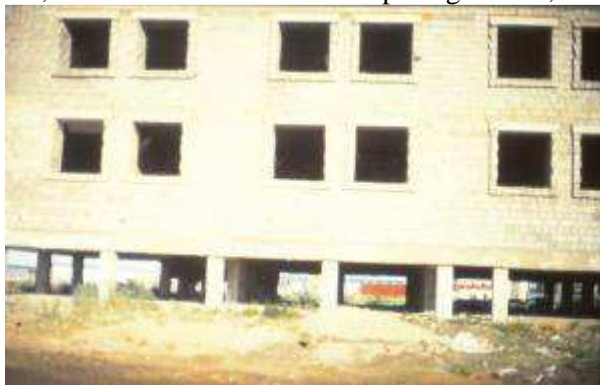
ein Neubau der zeigt, daß der Baukörper hoch über dem Boden beginnt, damit keine Wärme in den Permafrostboden fließt.
