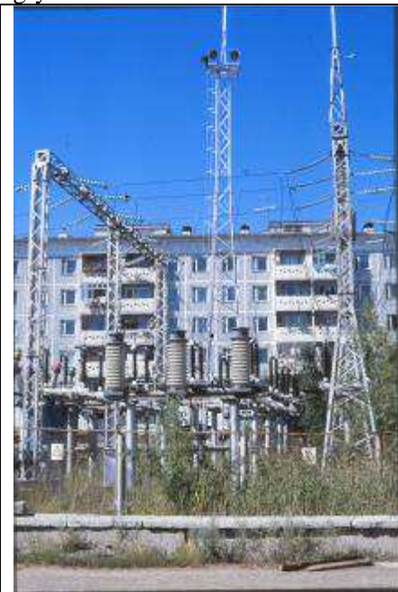
Energie scheint es genügend zu geben
