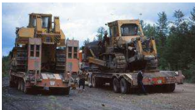
Mit gewaltigem Aufwand wird versucht die Straßen zu reparieren
