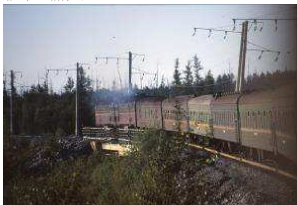
ein Teil der Strecke ist inzwischen elektrifiziert
